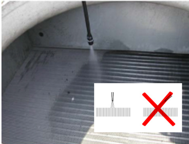
Figura 43: Ángulo permitido de chorro de agua de limpieza a baja presión contra el material del serpentín
