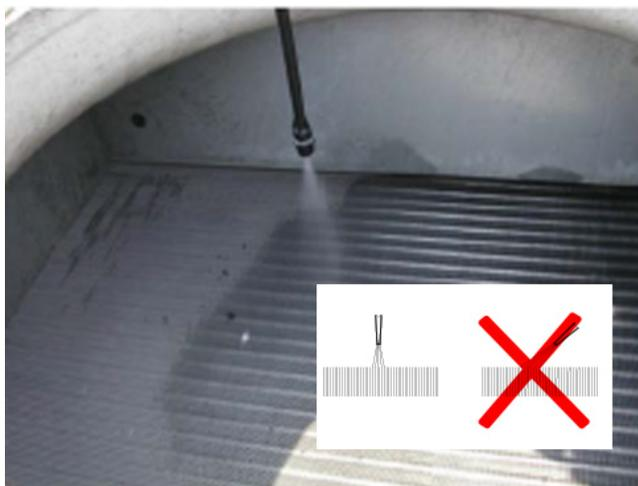
**Рисунок 43. Допустимый угол струи очищающей воды низкого давления относительно поверхности теплообменного блока**
