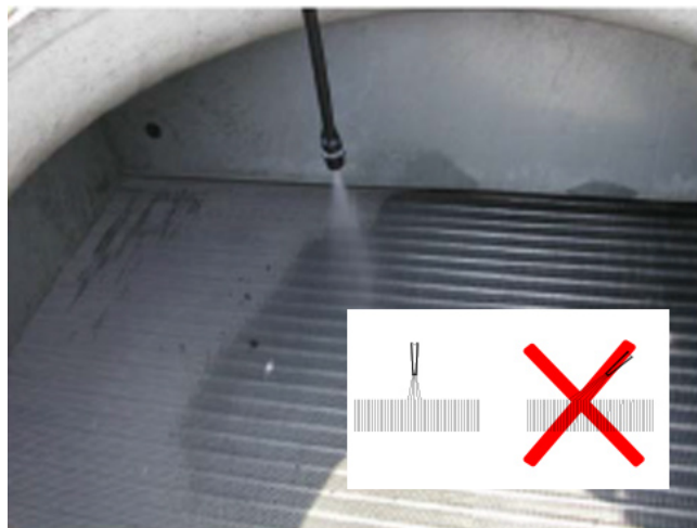
Slika 43: Dovoljen naklon nežnega vodnega curka na tuljavo
