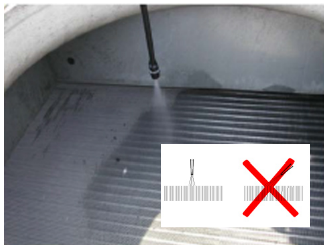
Figur 43. Tillåten vinkel för lågtrycksvattenstråle för rengöring av spolmaterial
